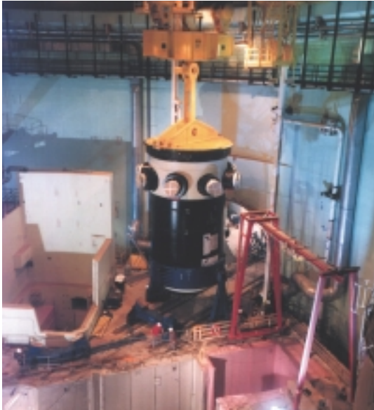
Cuve du réacteur de Civaux avant sa mise en place dans son emplacement au fond de la piscine (premier plan)
