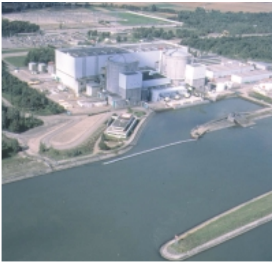
Centrale de Fessenheim
