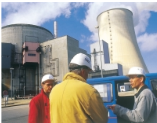
Inspection sur le site de Golfech
