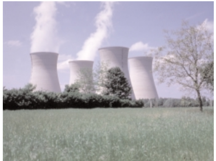
Centrale du Bugey
