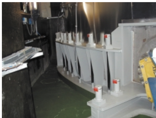
Renforcement des ancrages des réservoirs d'eau borée à la centrale du Bugey
