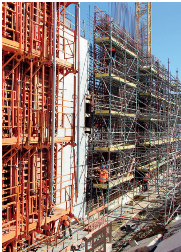
Chantier de construction de Diadem, septembre 2015.
