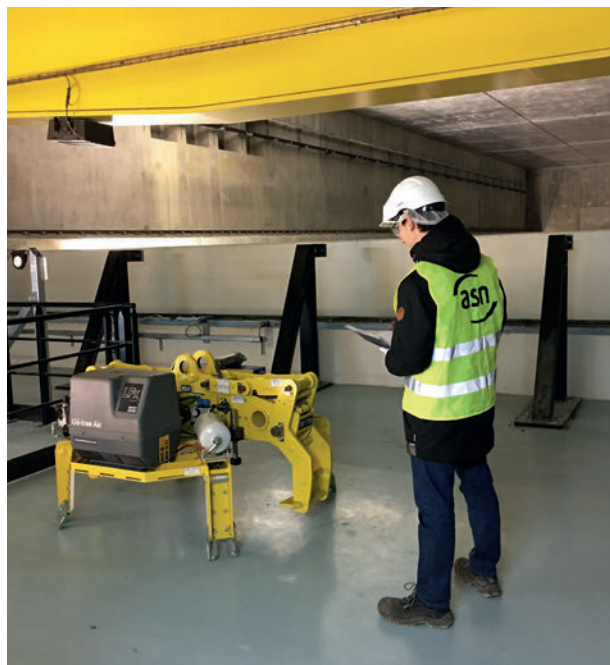
Chantier de construction d'Iceda, 2017.
