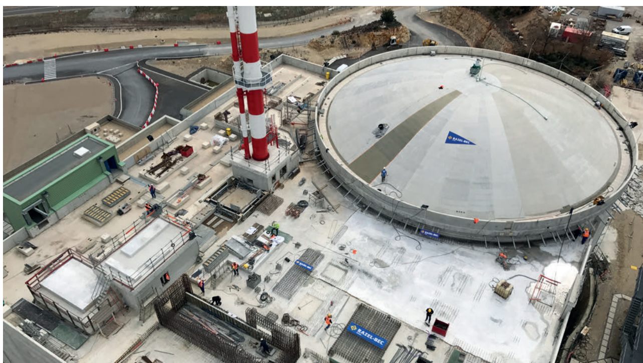
Travaux de toiture sur le RJH, mars 2017.
