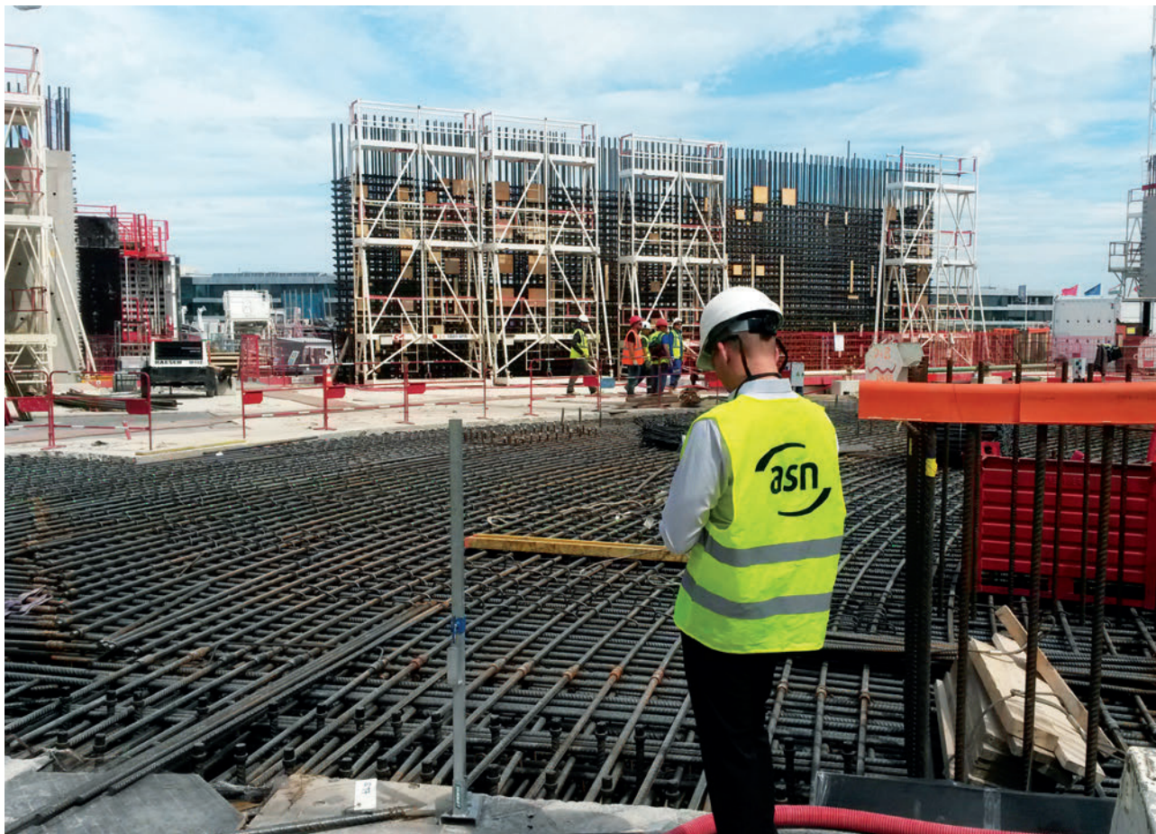
| Inspection de l'ASN sur le chantier du réacteur Tokamak de ITER, mai 2017.
